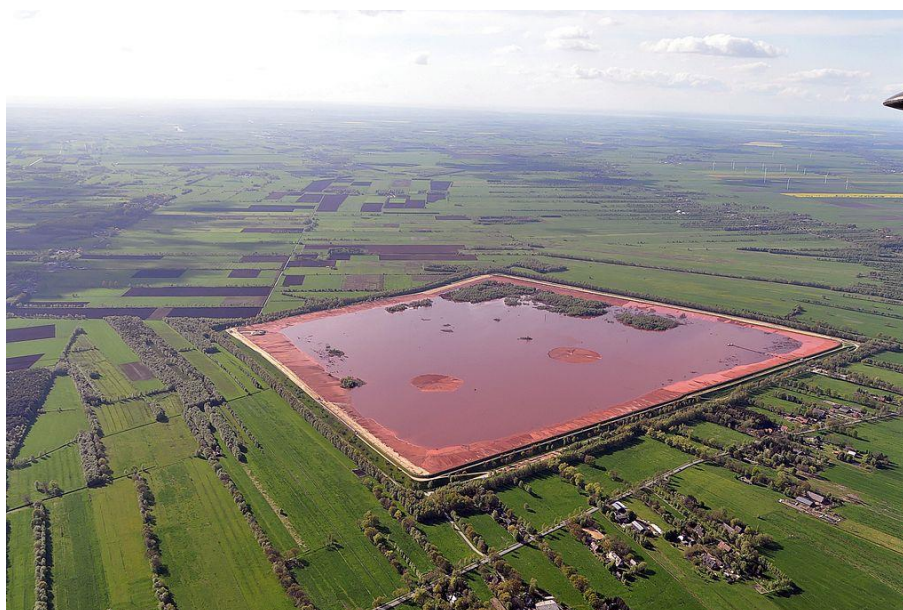
Рис. 1. Шламохранилище Уральского алюминиевого завода (УАЗ)
