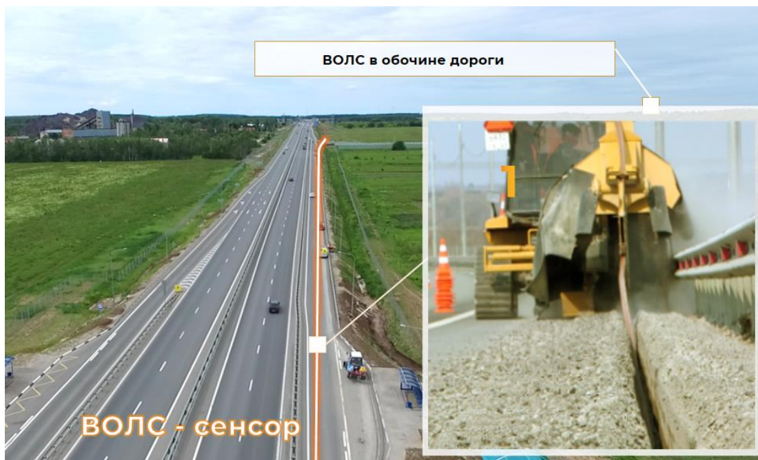
Рисунок 1 – Пример прокладки оптического микрокабеля в ЛКС ТМК в обочине автодороги.
