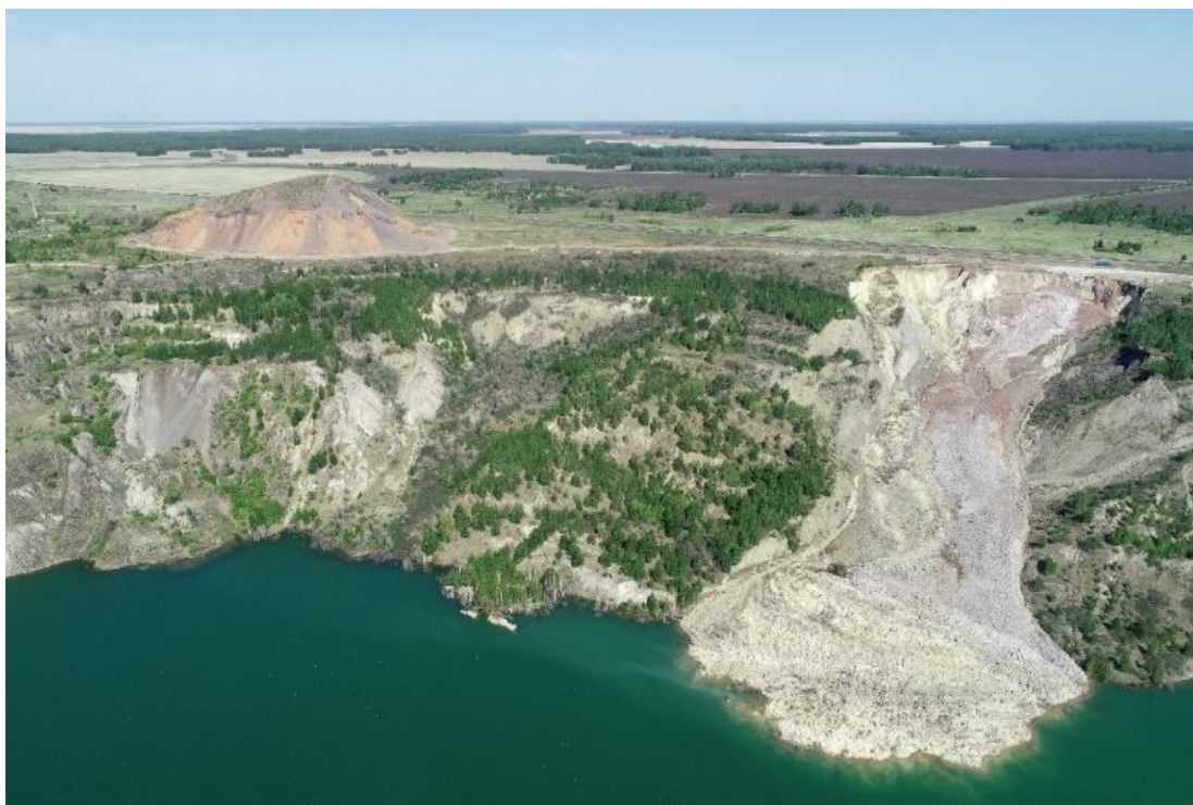
Рисунок 5. Оползень на восточном борту затопливаемого угольного разреза в пос. Красногорский Челябинской области (фото с БВС)
