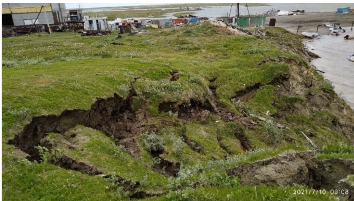
Рисунок 8 - Активный термоэрозионный процесс в районе села Сеяха, Ямальского района ЯНАО
