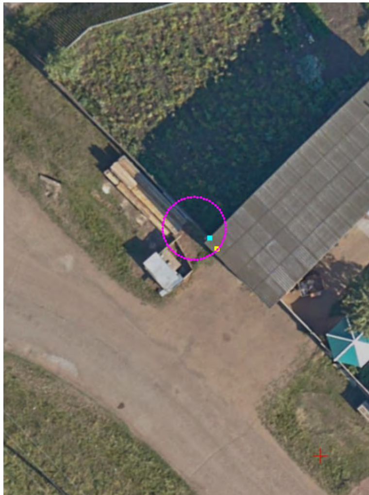
Рисунок 6 – На ОФП отсутствует видимость на точку.
