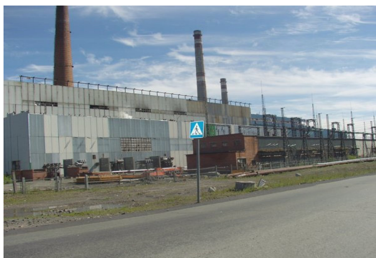
Рисунок 2 – Обогащительная фабрика Забайкальского ГОКа
