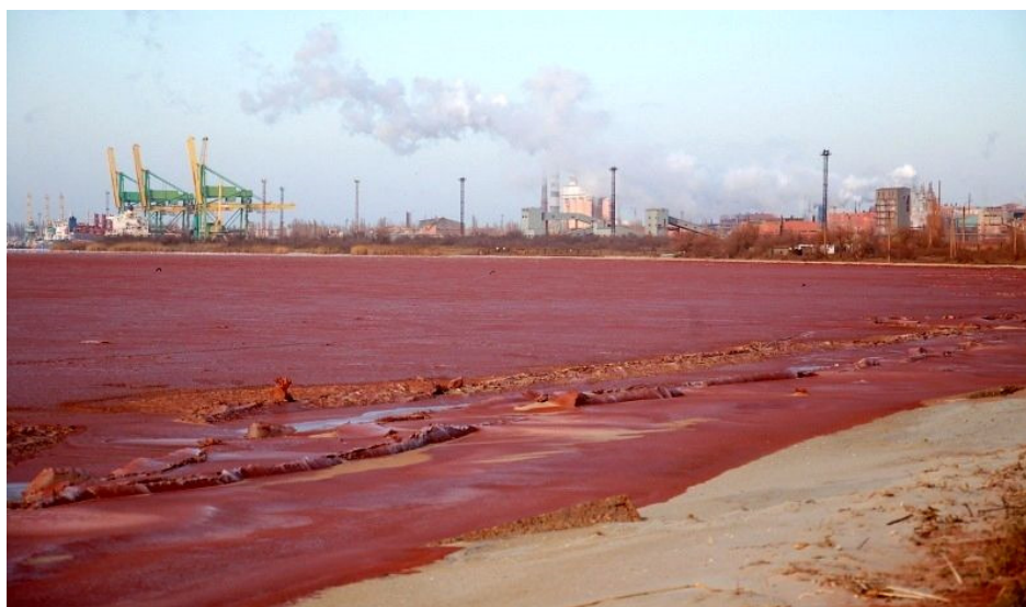
Рисунок 8 – Шламохранилище красных шламов Уральского алюминиевого завода
