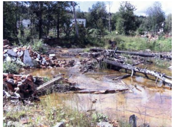
Рис. 4. - Самоизлив шахтных вод из штольни шахты им. 40 лет Октября (закрыта в 1997г), Кизеловский угольный бассейн (г. Губаха, Пермский край)
