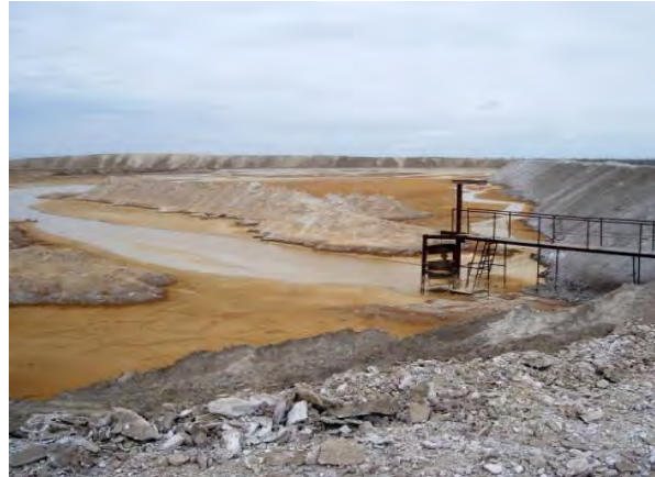
Рис. 5. – Хвостохранилище обогатительной фабрики
