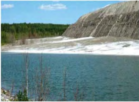
Рис. 1. - Рассолосборник и солеотвал на территории Вехнекамского месторождения калийно-магниевых солей (Соликамск, Пермский край)
