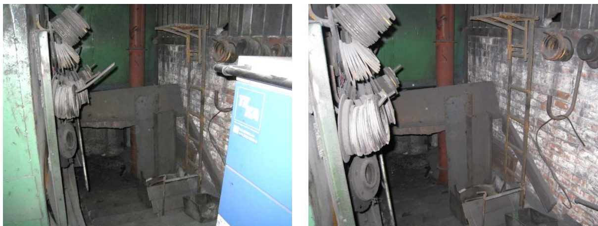
Рис.3 Пример устранения ОПС в ремонтном цехе
