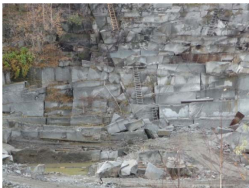
Рис. 2. Фрагмент юго-западного борта Сибирского карьера
