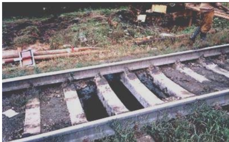
Рис. Карстовый провал на 1914 км перегона Богданович-Пышминская Свердловской железной дороги. 22.08.2001 г. (фото Горбовой С. В.).
