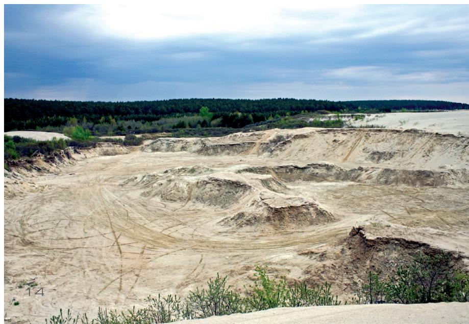
Хвостохранилище Березовского рудника на Урале содержит более 14 млн тонн отвальных хвостов. За счет естественного перераспределения материала в краевых частях хвостохранилища формируются сульфидные прослои (0,5–3 см) с песчаной массой при ширине таких прослоев десятки и длине — сотни метров. Содержание золота в таких прослоях в двух пробах 12,6 и 20,1 г/т при среднем содержании в хвостохранилище 0,2 г/т.
