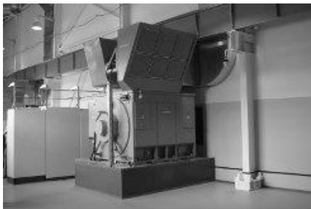
Рис. 1.8. Структурная схема и внешний вид электропривода газоперекачивающего агрегата
