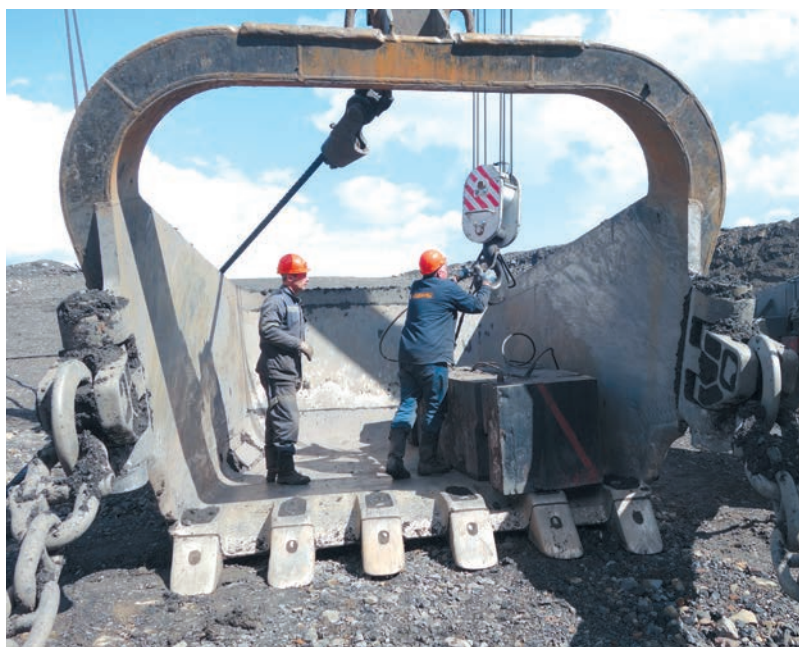
Рис. 3. Установка контрольных грузов 38 тонн в ковш 20 м 3 драглайна ЭШ 20.90С
