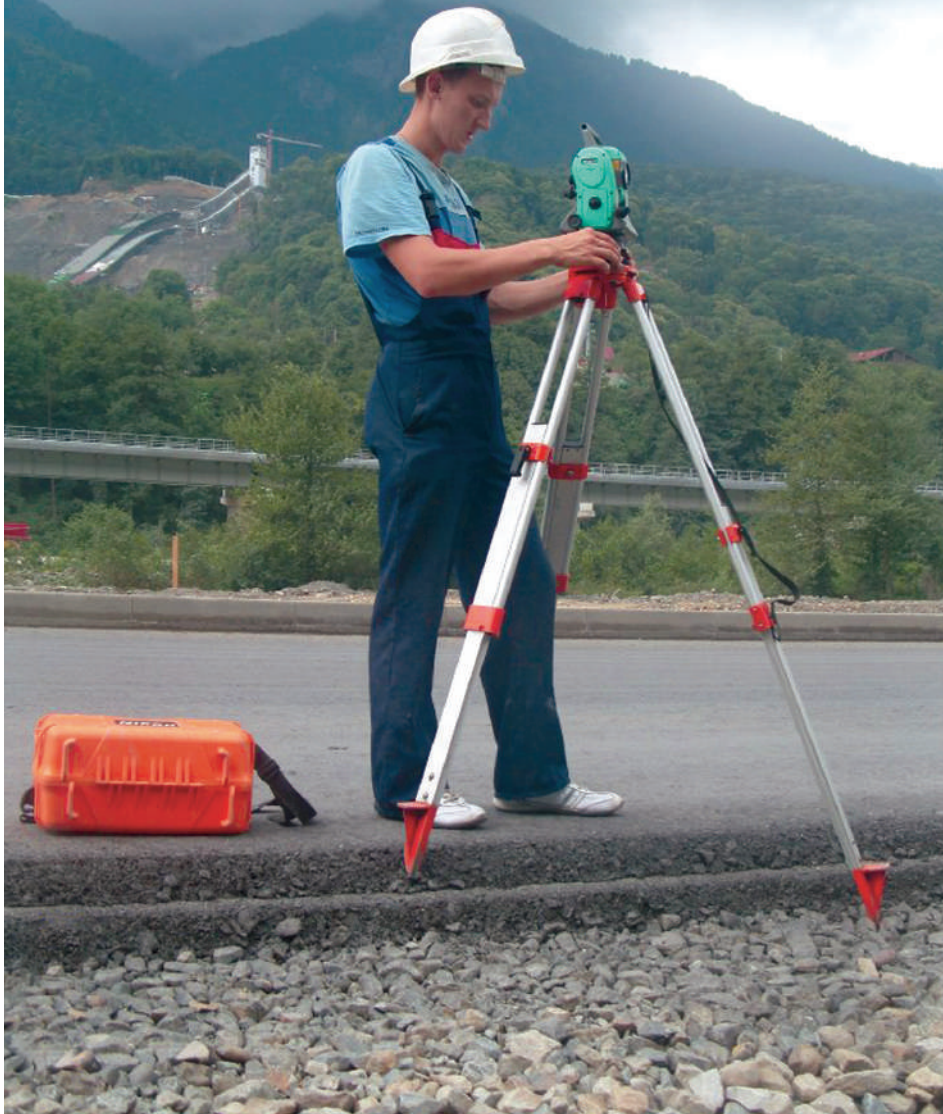
Александр Щеткин на строительстве коммуникационного тоннеля на Красной Поляне, г. Сочи
